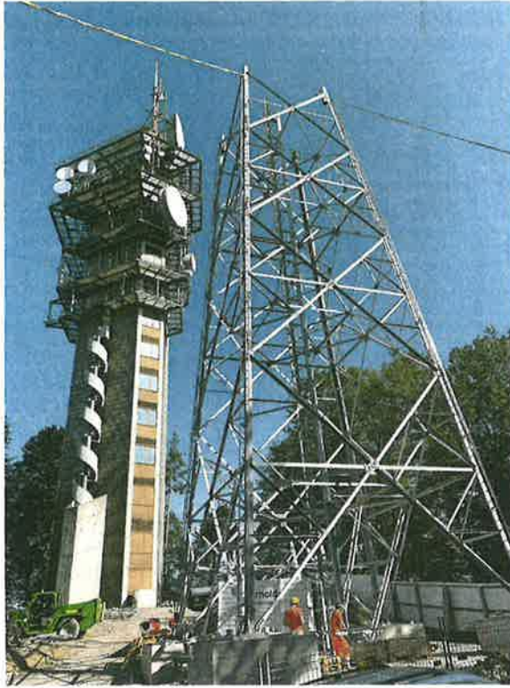
Alt und neu nebeneinander. Links der alte Betonturm auf der Felsenegg. Im November wird er in seiner Funktion durch den Neubau, einen eleganten Stahlgitterturm, abgelöst werden. (Bilder Stefan Schneider)
