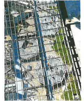
Durch den Gitterboden der Plattform des alten Turms sind Arbeiter auf den Plattformen des neuen Turms zu sehen.
