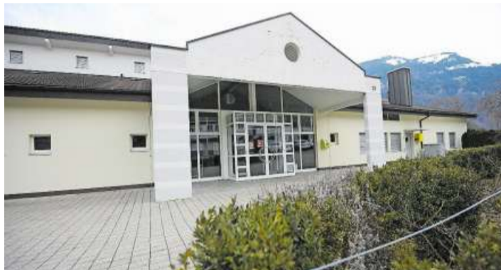
Die Mehrzweckanlage Steini soll eine neue Beleuchtung erhalten.
