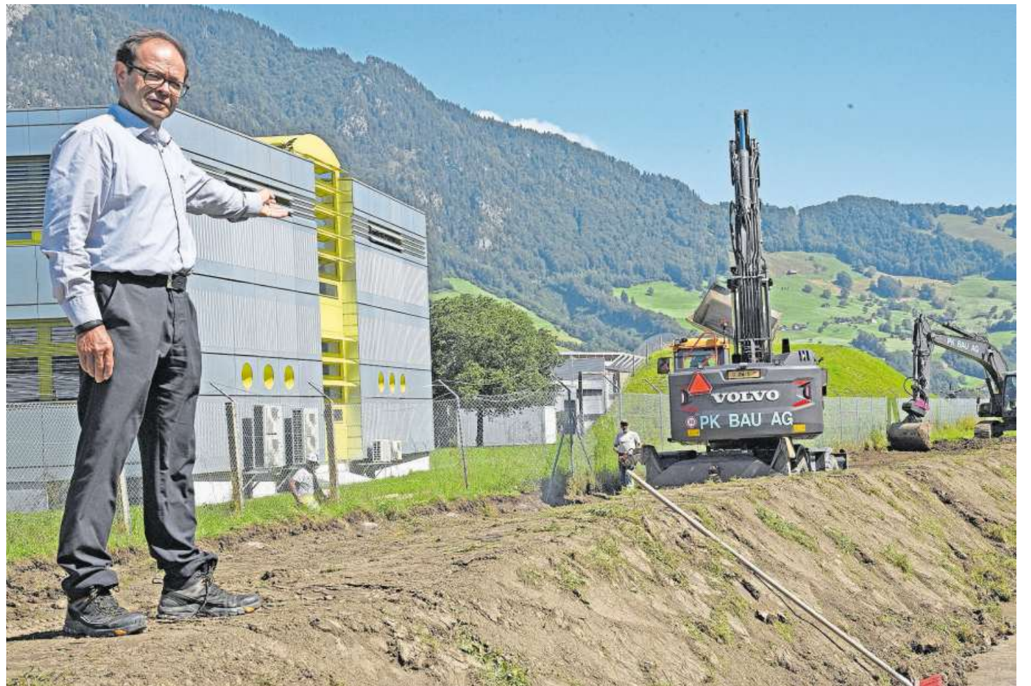
Regierungsrat Josef Hess beim Spatenstich.
