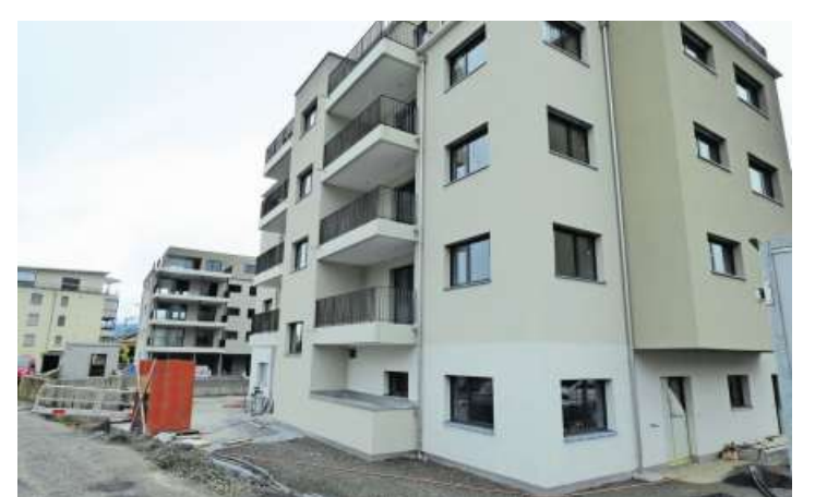
So sieht die Baustelle zurzeit aus.
